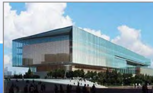
地源热泵制热 世博中心- EXPO Center
